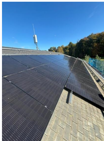
Figure 3 : Montage des modules PV
