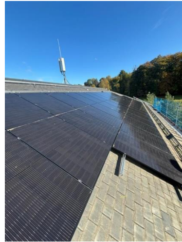
Abbildung 3: Montage der PV-Module
