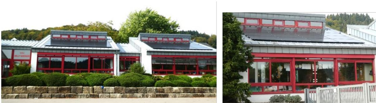
Figure 1 : Installation photovoltaïque de l'école Willy Goergen à Steinsel.
