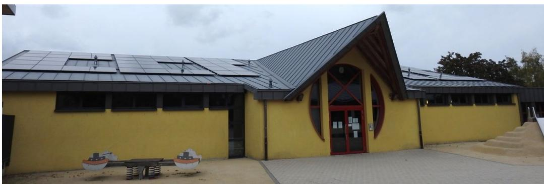
Figure 2 : Installation photovoltaïque sur le bâtiment scolaire C1 à Heisdorf.
