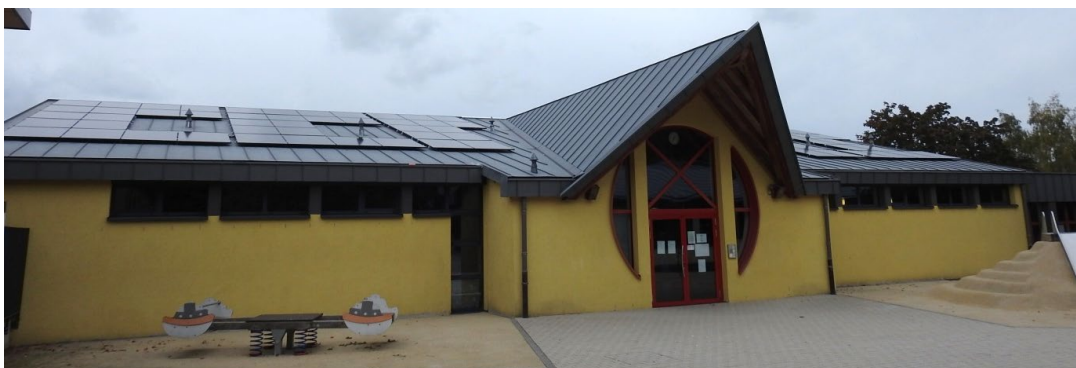
Abbildung 2: Photovoltaikanlage auf dem C1-Schulgebäude in Heisdorf.
