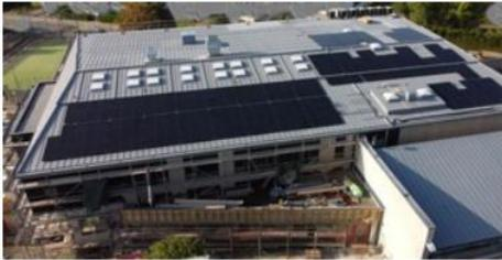
Konkret wurde auf dem Dach eines Erweiterungsbaus der Schule von Lintgen eine Photovoltaik-Anlage errichtet - mit 536 monokristallinen Solarmodulen mit jeweils 330 Wp (Fotos rechts). Die dort produzierte Energie hat eine geschätzte Jahresproduktion von 144000 kWh und kann somit 43 Haushalte mit Strom versorgen. Damals waren an diesem Projekt 109 Anteilhaber(innen) der Kooperative beteiligt, darunter 10 Mitglieder des Verwaltungsrats. Im September
